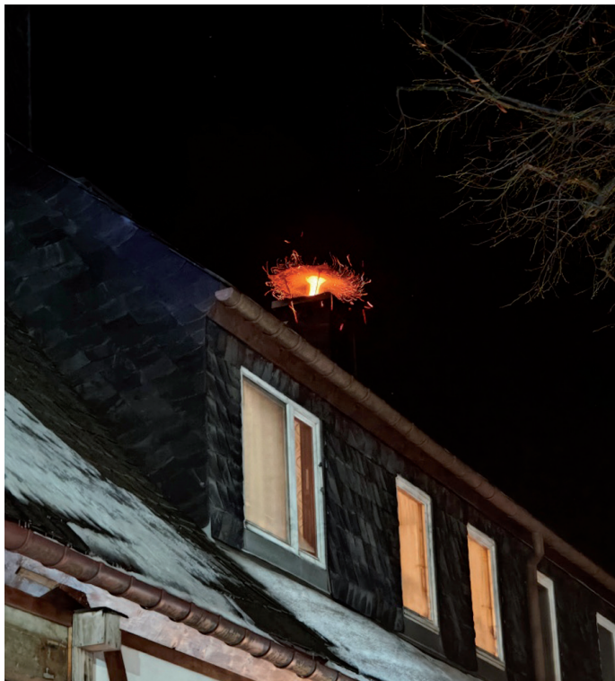
Der brennende Schornstein bei einem Einsatz in Tannenberg
