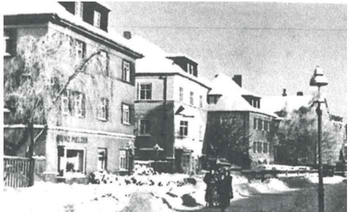
Von links: Schillerstraße 42, 40, 38, 36
