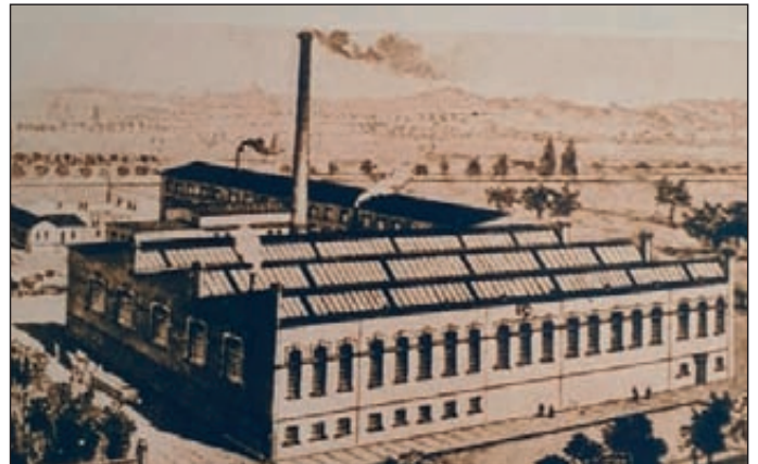
In der 1892 neu errichteten Fabrik waren ca. 100 Mitarbeiter tätig
