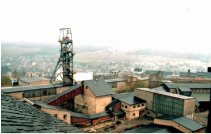
Blick über den Standort aus der Erzaufbereitung (Archivbild)
