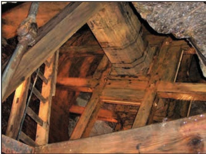
**Bild 3: Wasserrad am Alexander Schacht im Niveau des Tiefen Sauberger Stolln** (Foto Jäger)
